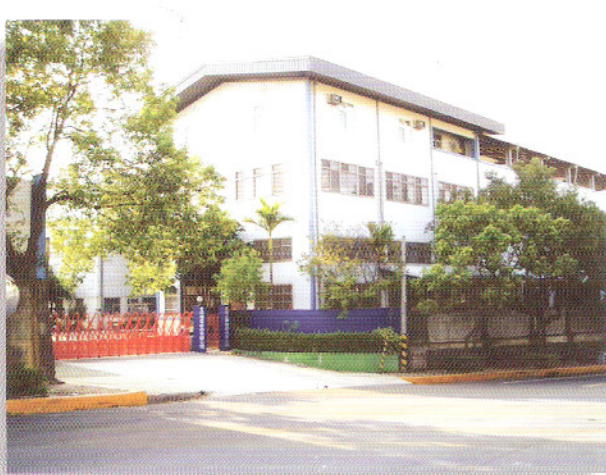
銅鑄一廠——鼓風機廠 Blowers Factory
